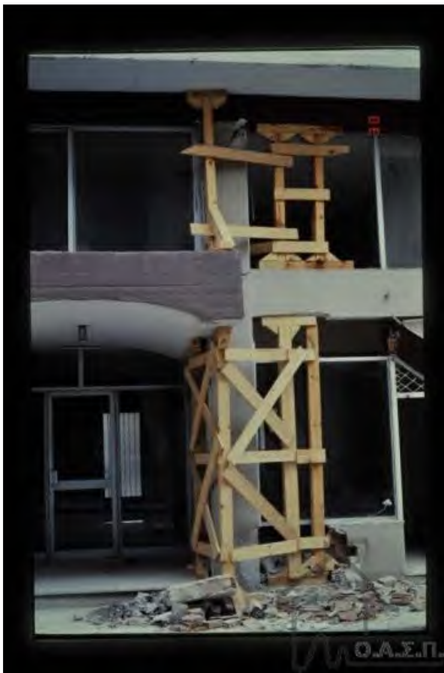
Φωτογραφία 6-11. Υποστύλωση κολονών ισογείου και ημιώροφου με ξύλινα συστήματα υποστύλωσης. (Σεισμός 1986, Καλαμάτα, πηγή: Φωτογραφικό αρχείο ΟΑΣΠ)
