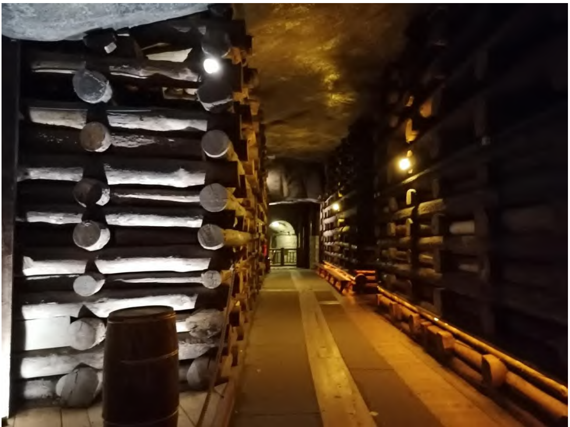
Φωτογραφία 2-5. Εκτεταμένη υποστήλωση τακαρίας για συγκράτηση οροφής ορυχείου (2020, “Wieliczka” Salt Mine, Wieliczka, Πολωνία).
