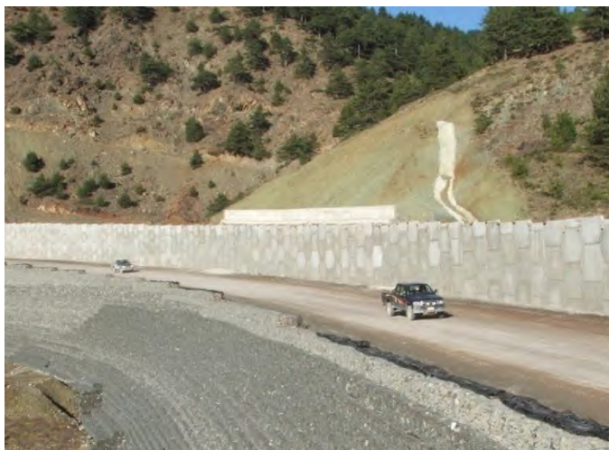
Φωτογραφία 6-5. Τοίχος αντιστήριξης στην Εγνατία Οδό.
