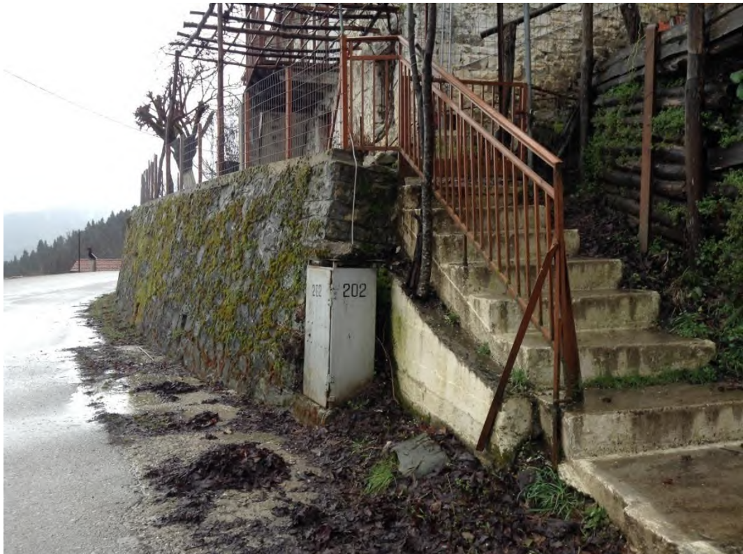
Φωτογραφία 6-4. Τοίχος αντιστήριξης για δημιουργία επιπέδου δόμησης.
