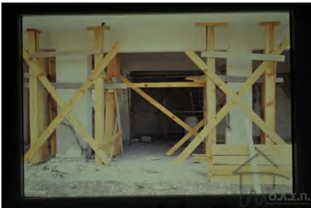
Φωτογραφία 2-4. Υποστύλωση κολώνας ισογείου (1986, Σεισμός Καλαμάτα, πηγή: Φωτογραφικό Αρχείο Ο.Α.Σ.Π.).
