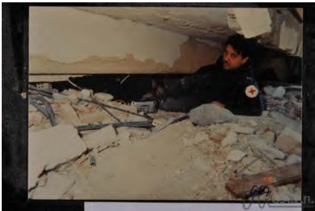
Φωτογραφία 6-15. Διατήρηση ανοίγματος διείσδυσης από το υπερκείμενο δοκάρι. (1986, Σεισμός Καλαμάτας, πηγή: Φωτογραφικό Αρχείο Ο.Α.Σ.Π.)
