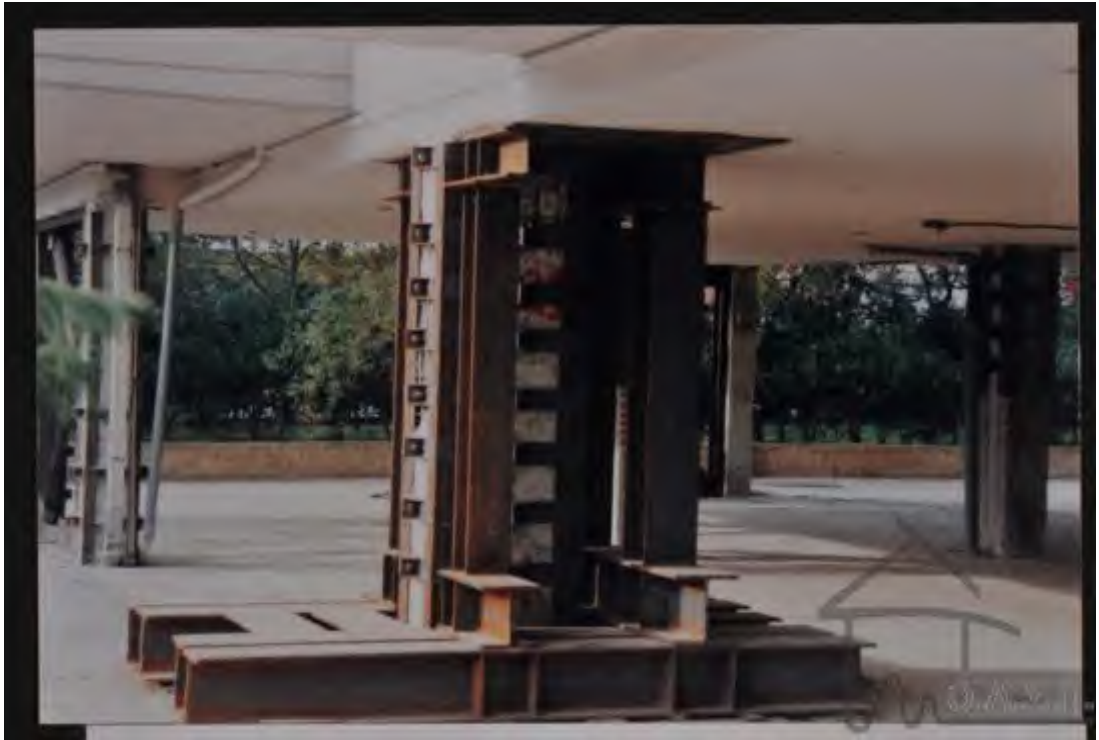
Φωτογραφία 1-4. Υποστύλωση κολώνας με περίσφυξη (1999, Σεισμός Αθήνα, πηγή: Φωτογραφικό Αρχείο Ο.Α.Σ.Π.).
