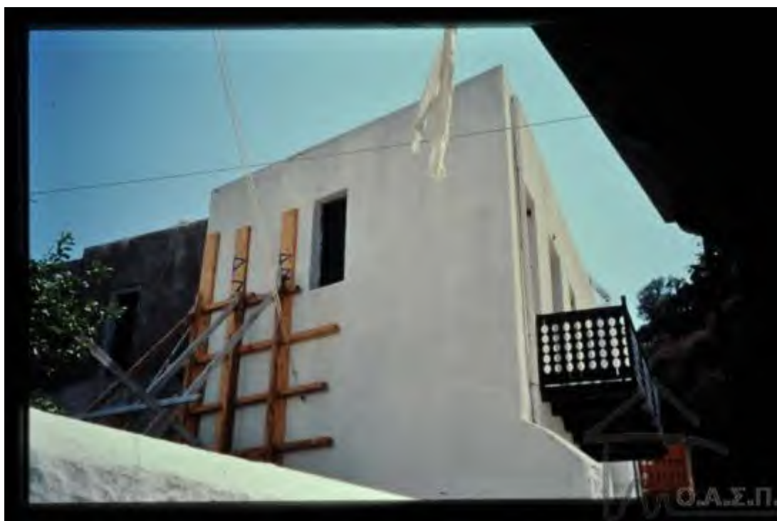
Φωτογραφία 1-8. Εφαρμογή συστήματος αντιστήριξης (1996, Σεισμός Νίσυρος, πηγή: Φωτογραφικό Αρχείο Ο.Α.Σ.Π.).
