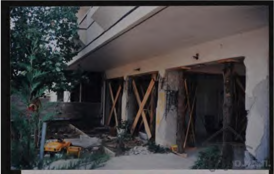
Φωτογραφία 4-6. Αντιστήριξη πλαισίων με διαγώνιους συνδέσμους (πηγή: Φωτογραφικό Αρχείο Ο.Α.Σ.Π.)
