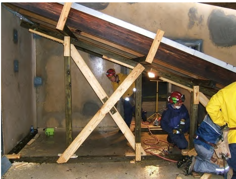
Φωτογραφία 3-1. Υποστύλωση κεκλιμένης πλάκας (πηγή: TEEX, Texas A&M Engineering Extension Service, url: https://teex.org )
