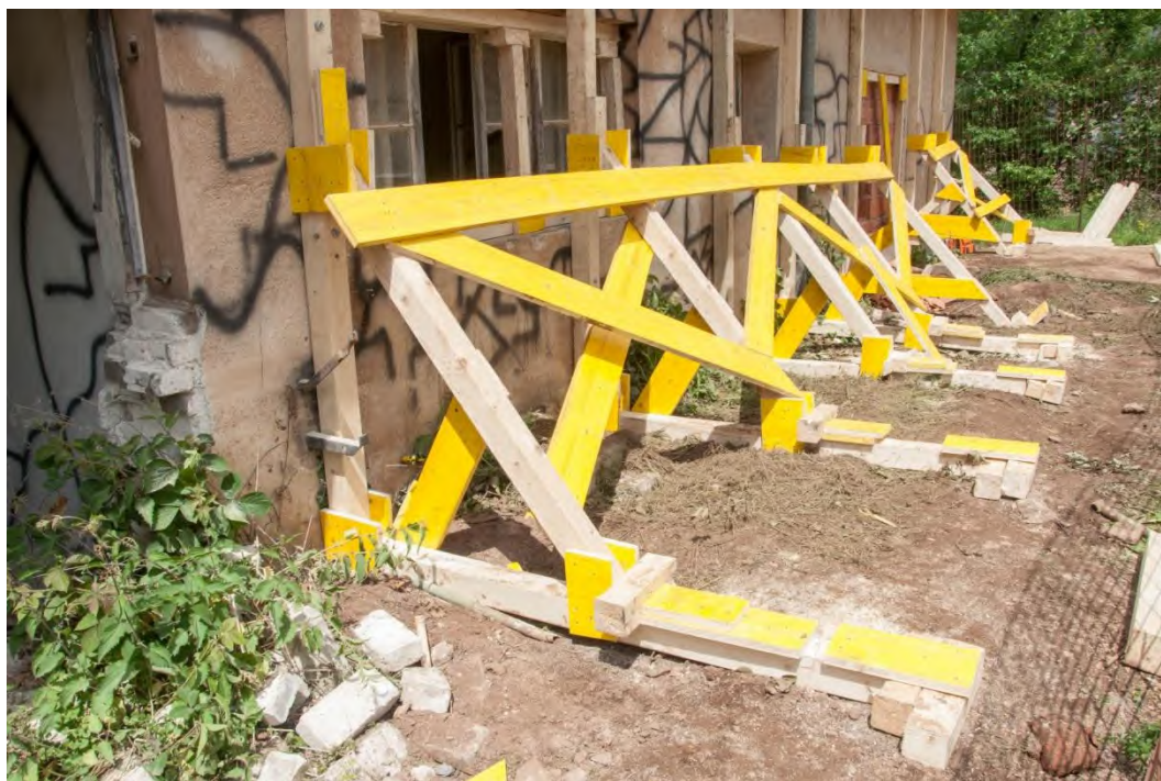
Φωτογραφία 4-3. Εφαρμογή εκτεταμένου συστήματος αντιστήριξης ενιαίας βάσης (2018, EuModex, GR/MUSAR1/ATH - 1η ΕΜΑΚ, Austria/Eisenerz).
