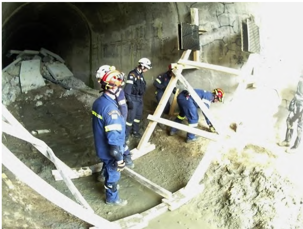
Φωτογραφία 4-4. Αντιστήριξη με αντηρίδες ιπτάμενου τύπου , για σταθεροποίηση σήραγγας (2019, EuModex, GR/MUSAR2/THESS - 2η ΕΜΑΚ, Bulgaria/Montana)
