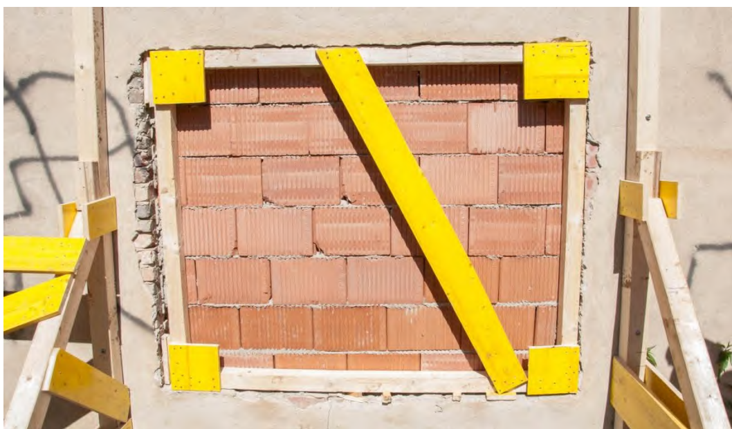
Φωτογραφία 5-2. Ξύλινο σύστημα υποστήριξης παραθύρου (2019, EuModex, GR/MUSAR1/ATH - 1η ΕΜΑΚ, Austria/Eisenerz)
