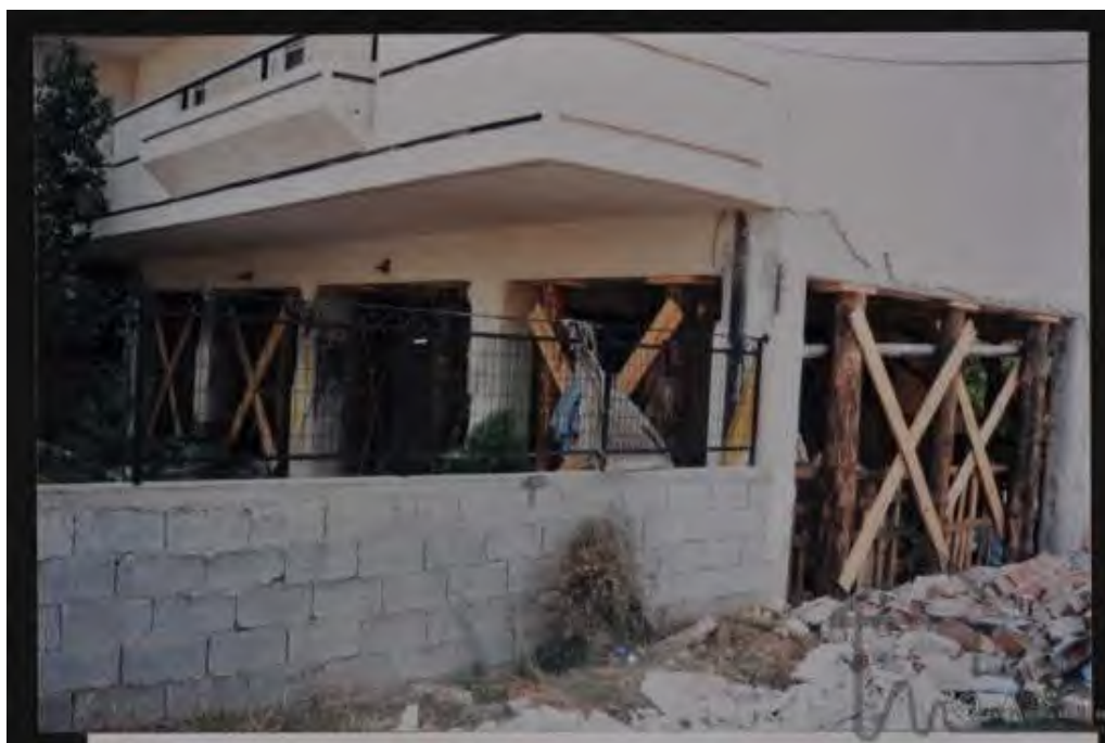
Φωτογραφία 6-8. Αντιστήριξη πυλωτής με διατάξεις διαγωνίων δοκών. (Σεισμός 1999 Αθήνα, πηγή: Φωτογραφικό Αρχείο Ο.Α.Σ.Π.)
