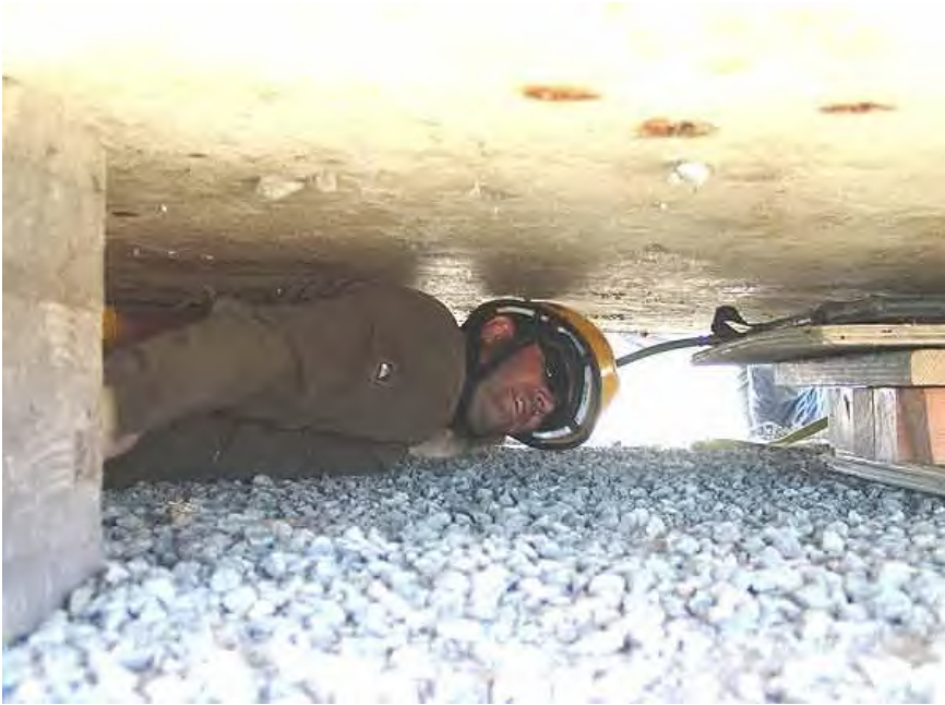
Φωτογραφία 6-16. Παράδειγμα υποστήλωσης περιορισμένου χώρου με χρήση τακαρίας. (πηγή: NASA Ames Research Center - Disaster Assistance and Rescue Team (DART)/ http://dart.arc.nasa.gov )
