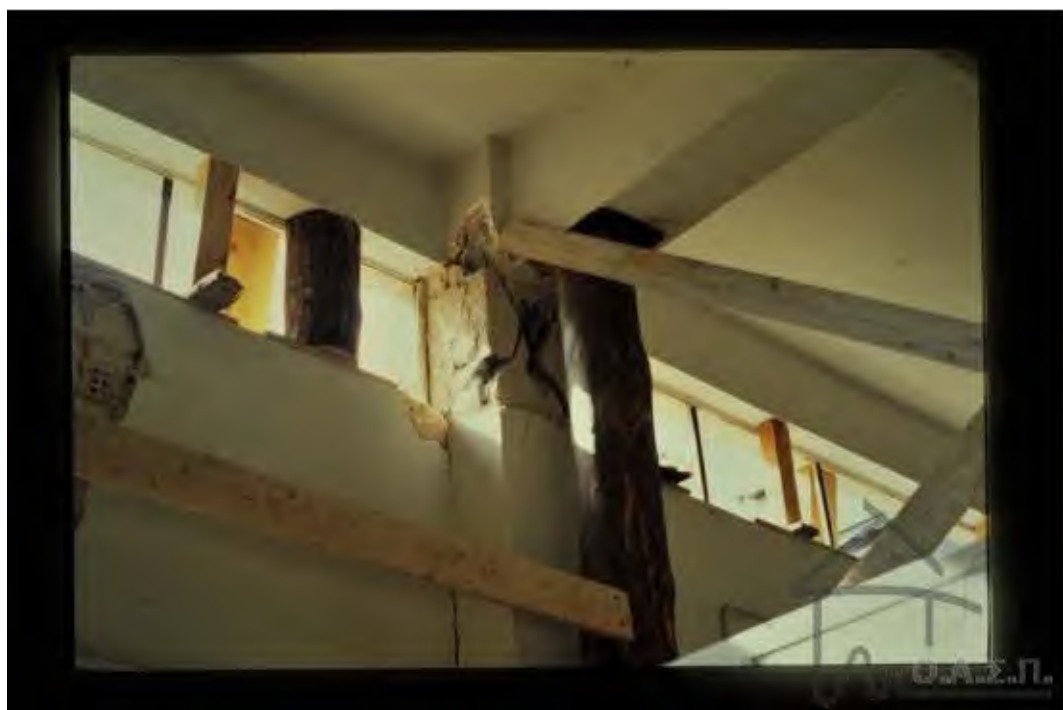
Φωτογραφία 6-9. Υποστύλωση κολονών με κορμούς δέντρου - χονδροσυλεία. (Σεισμός 1986, Καλαμάτα, πηγή: Φωτογραφικό αρχείο ΟΑΣΠ)
