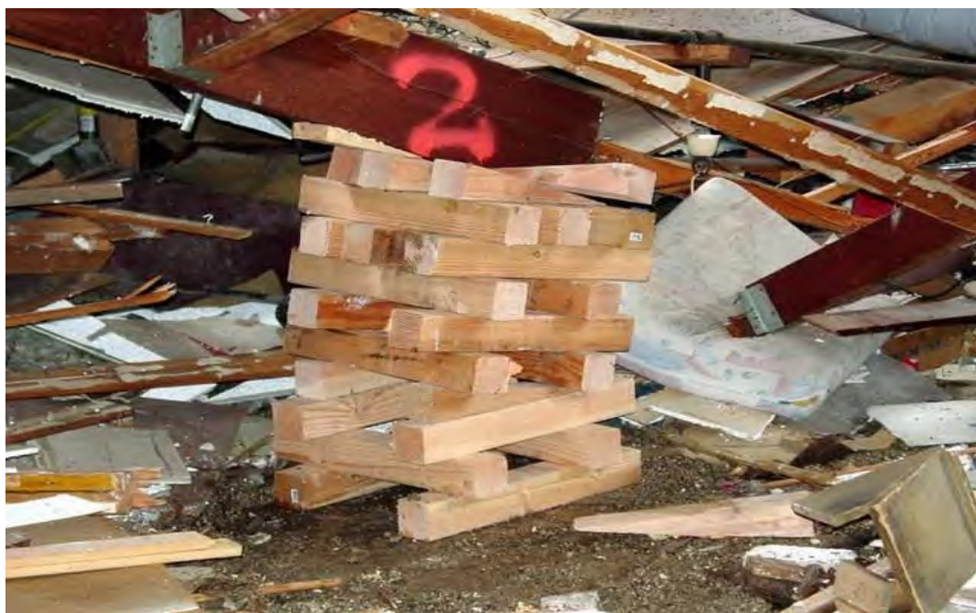
Φωτογραφία 1-7. Κεκλιμένη υποστύλωση (πηγή: FRDDisaster International )
