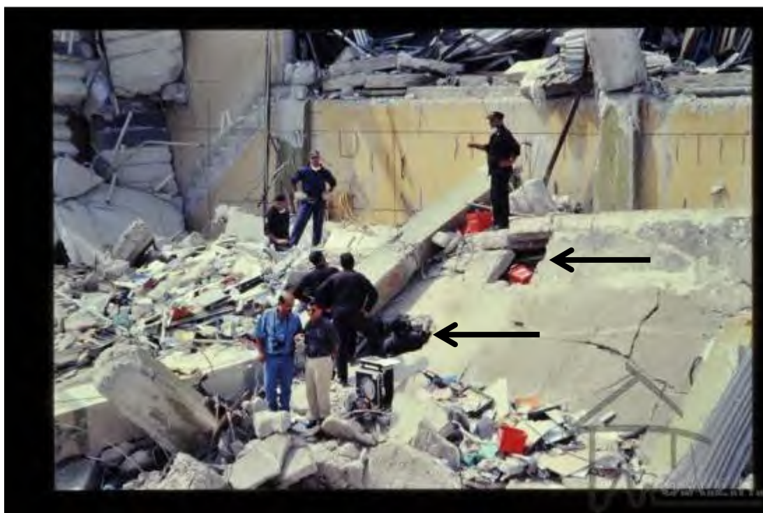
Φωτογραφία 6-14. Διάνοξη οπών σε πλάκα για κατακόρυφη διείσδυση, κοντά σε δοκάρια (επάνω) και στο μέσο (κάτω). (1990, Σεισμός Αθήνα, πηγή: Φωτογραφικό Αρχείο Ο.Α.Σ.Π.)
