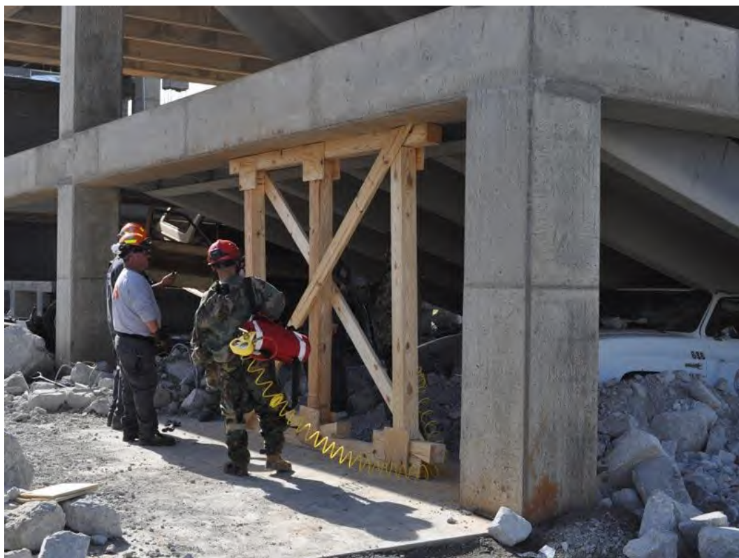
Φωτογραφία 6-10. Υποσύλωση κολώνας με τοποθέτηση συστήματος ξύλινων κατακόρυφων υποστυλωμάτων στην δοκό της προς υποσύλωση κολώνας. (πηγή: Guardian Centers - url: http://guardiancenters.com )
