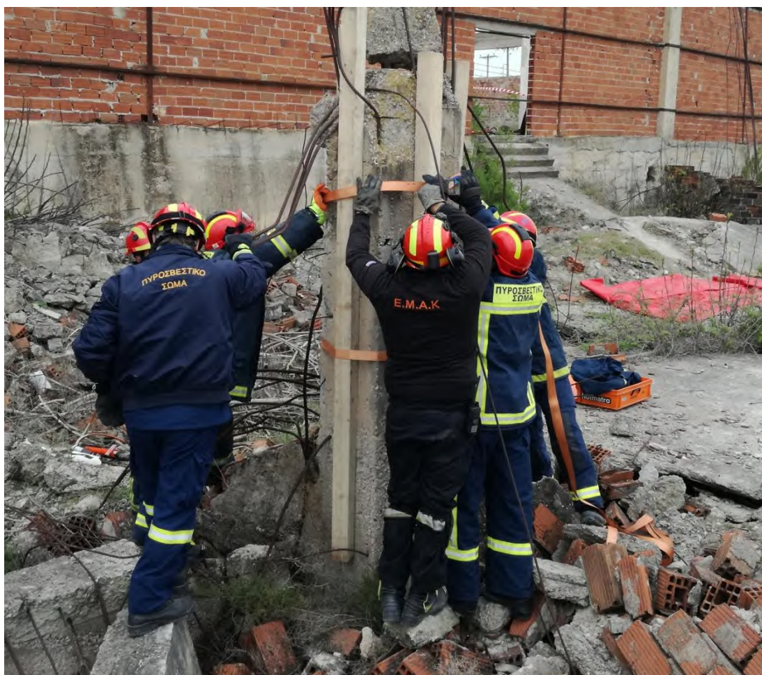
Φωτογραφία 1-5. Υποσύλωση, μέσω περίσφιξης, κολώνας ισογείου (2018, GR/MUSAR2/THESS - 2η ΕΜΑΚ, Θεσσαλονίκη).
