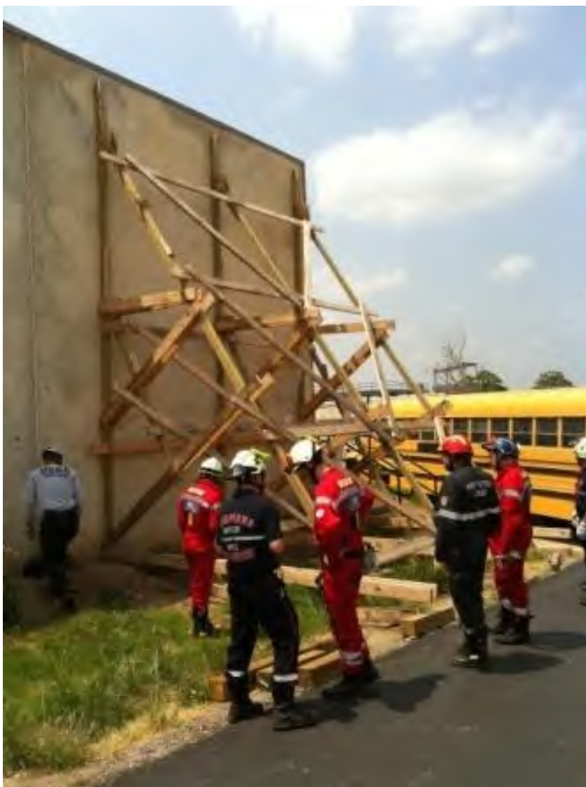
Φωτογραφία 4-2. Κατασκευή πολύπλοκου συστήματος αντιστήριξης με αντηρίδες (πηγή: USAR Belgium).
