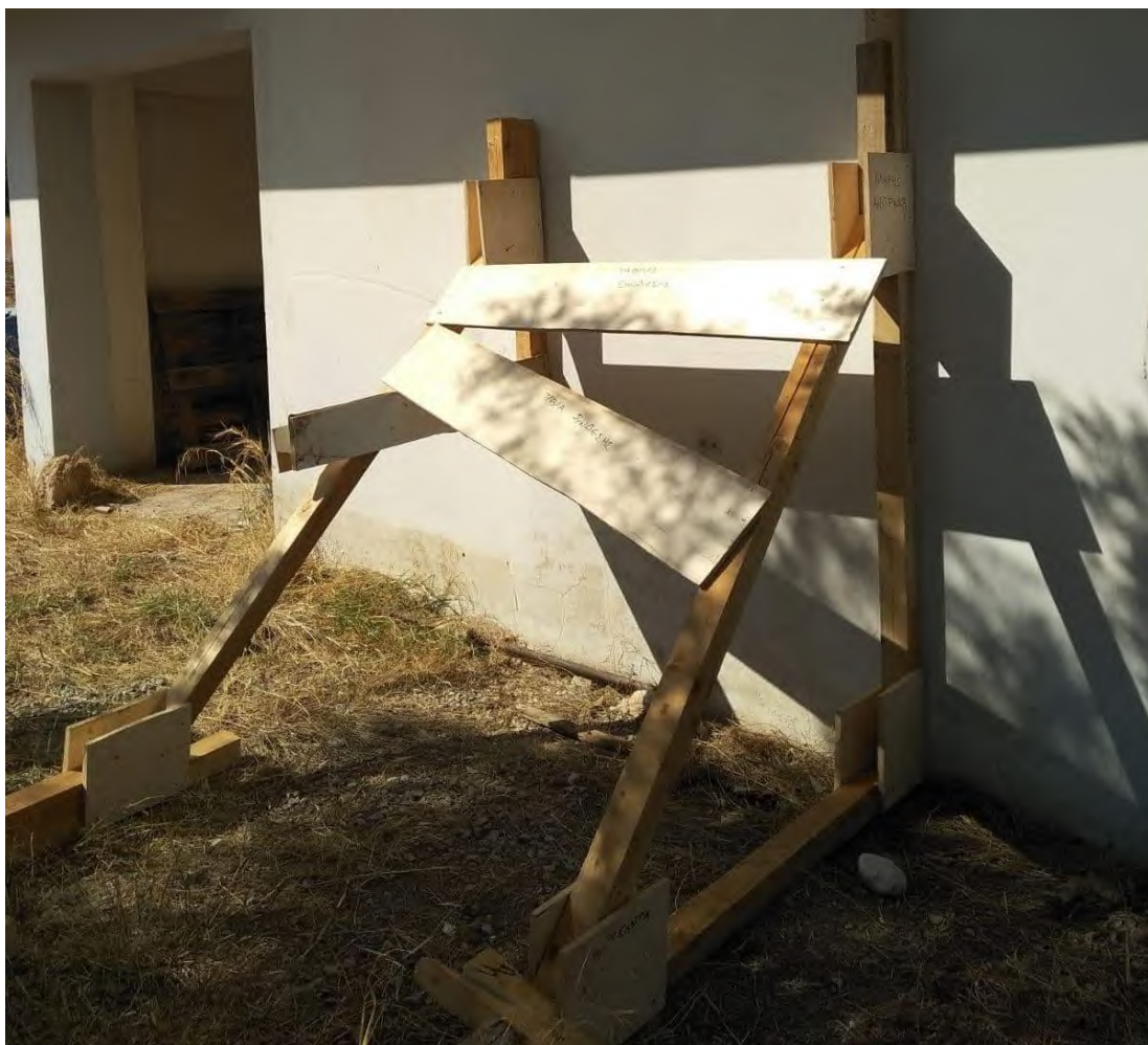
Φωτογραφία 4-1. Αντιστήριξη με αντηρίδες μεικτής βάσης (2019, GR/MUSAR1/ATH - 1η ΕΜΑΚ, Αθήνα).
