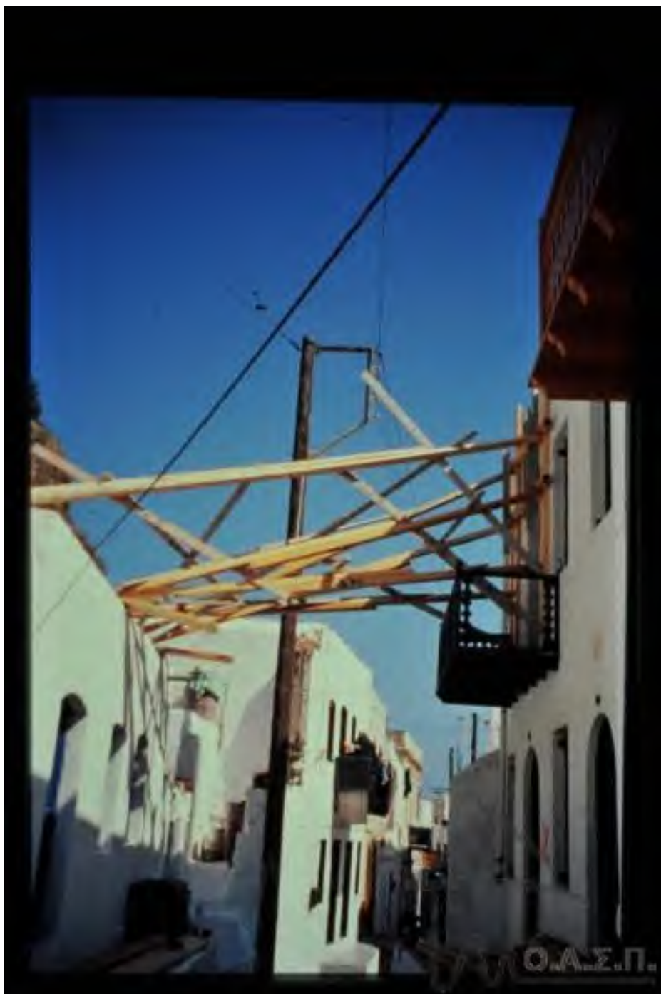
Φωτογραφία 1-6. Εφαρμογή αντιστηρίξεων για την αποφυγή κατάρρευσης τμημάτων τοιχοποιίας που έχουν αστοχήσει από σεισμό (1996, Σεισμός Νίσυρος, πηγή: Φωτογραφικό Αρχείο Ο.Α.Σ.Π.).
