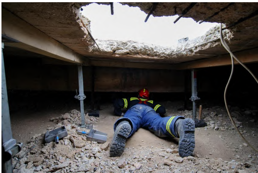
Σχήμα 6-36. Υποστύλωση ανοίγματος μετά από κατακόρυφη διεύθυνση (2018, Konstantinos Toumparidis)
