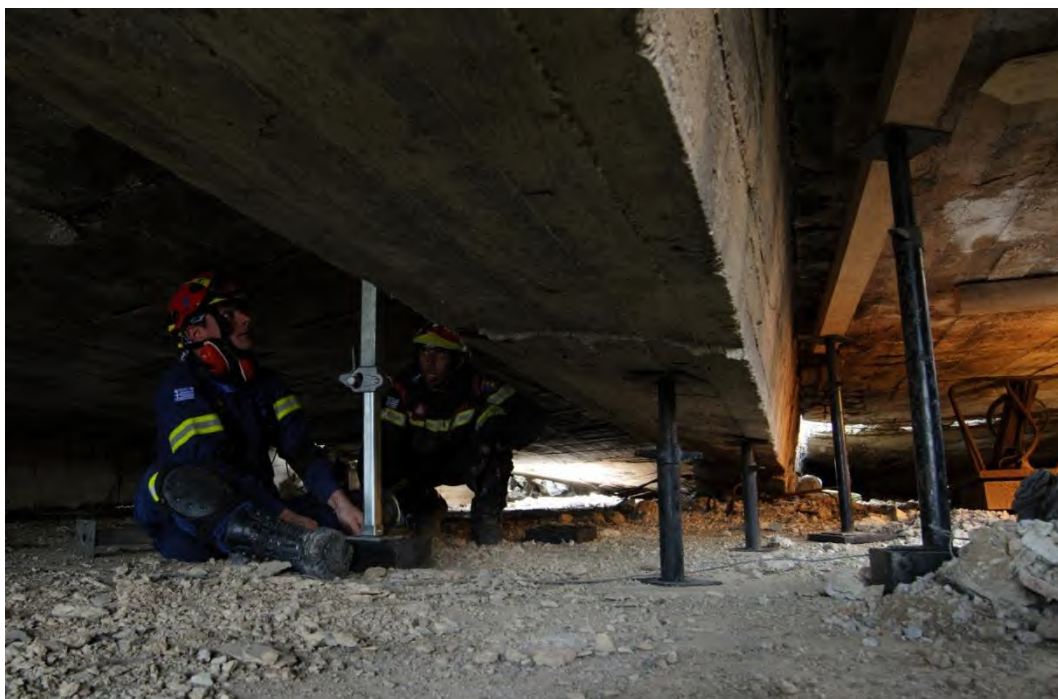
Σχήμα 6-41. Διαδικασία υποστήλωσης δοκαριού και τμήματος πλάκας εκατέρωθεν της δοκού μετά από οριζόντια διείσδυση κάτω από δοκό (2018, Konstantinos Toumparidis)
