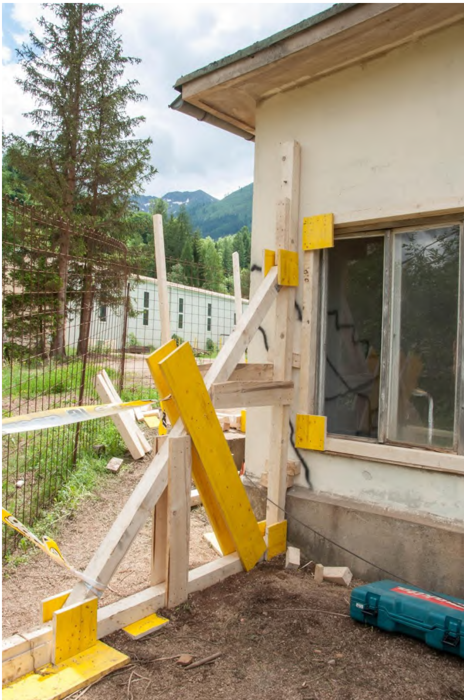
Φωτογραφία 6-3. Αντιστήριξη στις γωνίες του κτιρίου για περιορισμό των βλαβών (2018, EuModex, GR/MUSAR1/ATH - 1η ΕΜΑΚ, Austria/Eisenerz)
