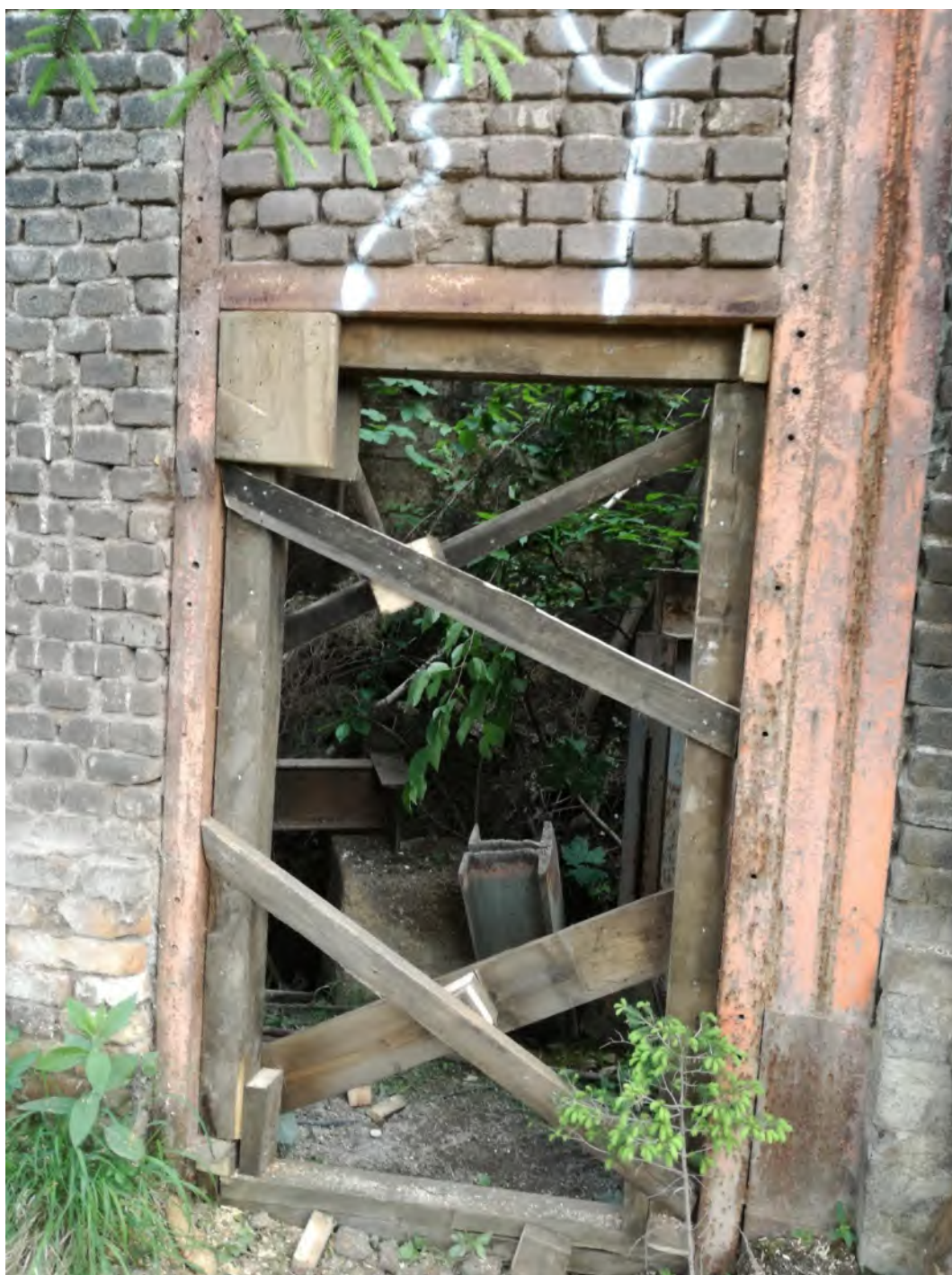
Φωτογραφία 6-13. Υποστήριξη ανοίγματος πόρτας, με χονδροξυλεία, για την εξασφάλιση ασφαλούς εισόδου. (2018, EuModex, Austria/Eisenerz)
