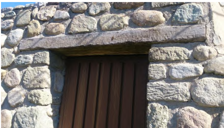
Φωτογραφία 1-2. Οριζόντιο ξύλινο ανώφλι πόρτας (Ιερά Μονή Αγίας Τριάδας, Μετέωρα)
