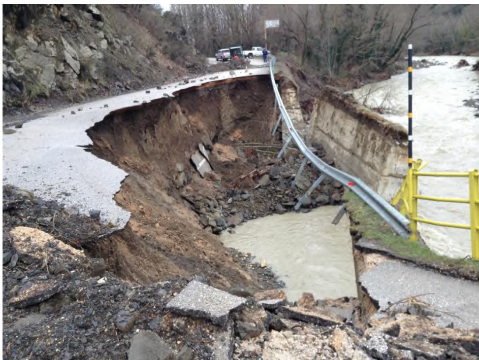
Φωτογραφία 6-6. Κατάρρευση τοίχου αντιστήριξης στο Δήμο Μακρακώμης. (πηγή: Αρχείο Ηλία Αναστάσιου, Πολιτικού Μηχανικού MSc)
