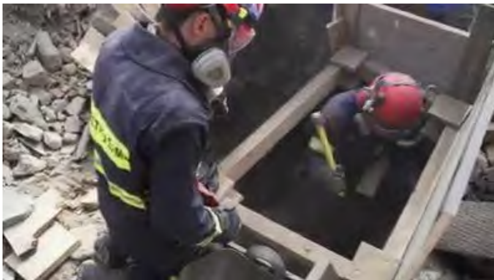
Φωτογραφία 4-5. Αντιστήριξη σκάμματος με χρήση οριζοντίων ξύλινων δοκών. (2019, EuModex, GR/MUSAR1/ATH - 1η EMAK, Portugal/Fogueteiro)
