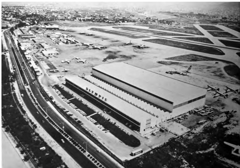
Ο αερολιμένας του Ελληνικού μέχρι το 1969 περιοριζόταν στον Δυτικό Αεροσταθμό, ο οποίος στη συνέχεια χρησιμοποιήθηκε αποκλειστικά από την Ολυμπιακή Αεροπορία. (ΥΠΑ, "Χθες, σήμερα, αύριο.", έκδοση ΥΠΑ, Νοέμβριος 1970)
