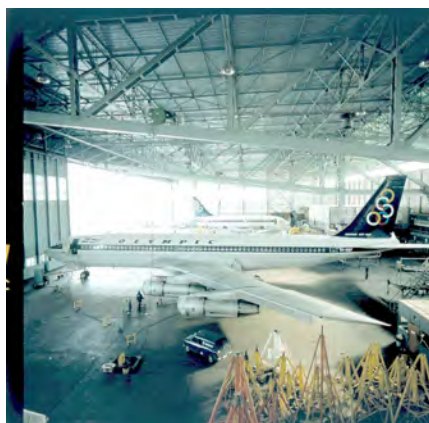
Το υπόστεγο που κατασκευάστηκε το 1965 στον Δυτικό Αεροσταθμό του Ελληνικού για τις γενικές επισκευές των Μπόϊνγκ 707 όπως ήταν γύρω στο 1977. (αρχείο ΟΑ)
