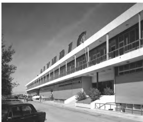
Για την εξυπηρέτηση των νέων Μπόϊνγκ 707 το 1965 κατασκευάστηκαν νέες εγκαταστάσεις για την Τεχνική Βάση στον Δυτικό Αεροσταθμό του Ελληνικού. (αρχείο ΟΑ)
