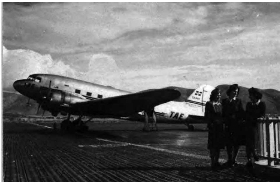
Το αεροδρόμιο του Ελληνικού μεταπολεμικά, στρώθηκε με Μεταλλικό Πλέγμα Επίστρωσης εδάφους (PSP) για να μην βουλιάζουν τα βαρύτερα πλέον αεροσκάφη στο χώμα σε περίπτωση βροχής (1949).
