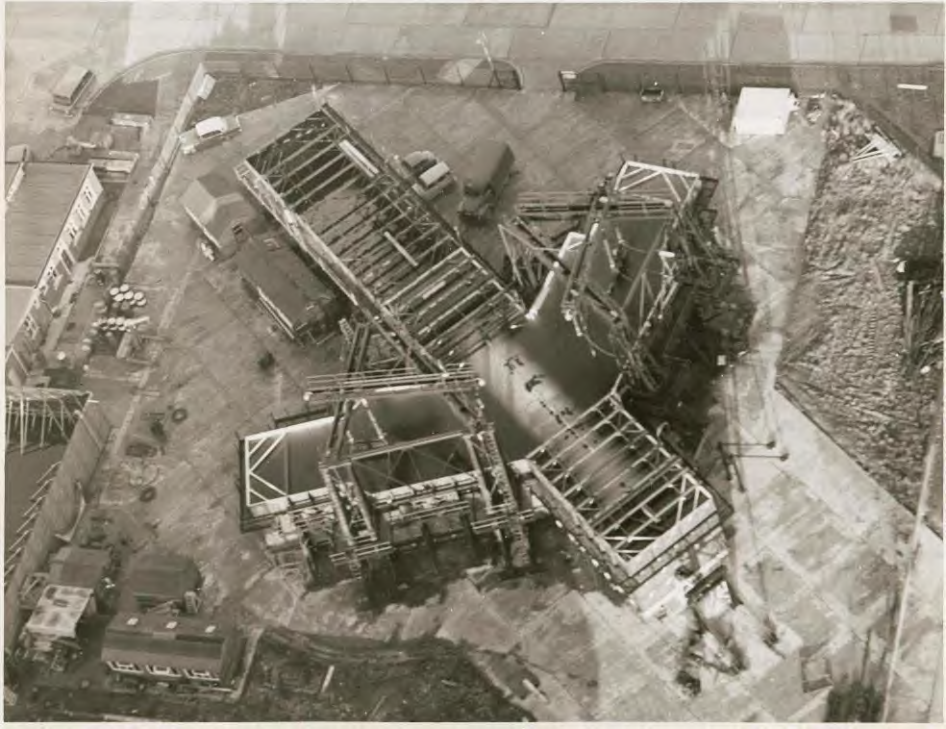
Εικόνα 8 De Havilland Δοκιμή Συμπίεσης Θαλάμου Tristar. Μετά τα ατυχήματα με τον κομήτη, δοκιμές σαν αυτές έγιναν υποχρεωτικές για τους κατασκευαστές.
